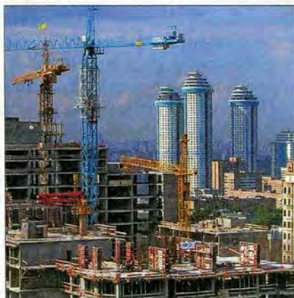
Рис. 253. Большое строительство – рабочие места
