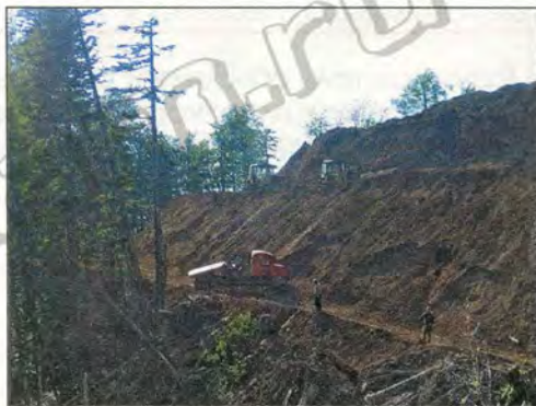
Рис. 221. Строительство дороги на склоне Кавказских гор
