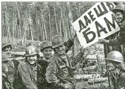
Рис. 247. Комсомольцы на строительстве БАМа
